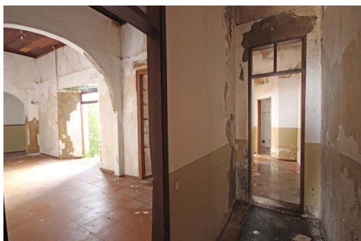
Antes da intervenção
