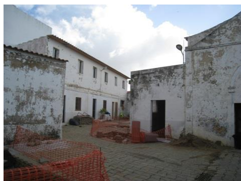
Antes da intervenção
