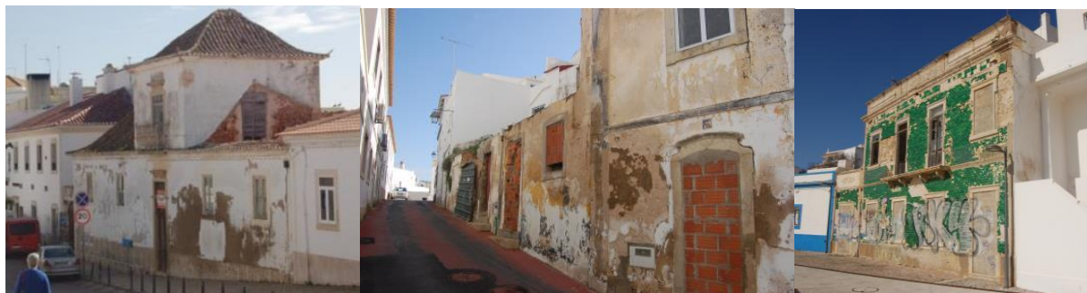
Figura 6.3_Edifícios em ruína ou em mau estado na área do PARU (2016)
