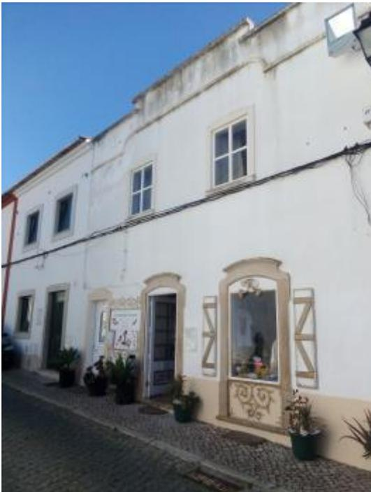
Figura 57. Exemplo de edifícios com cabos elétricos expostos nas fachadas
