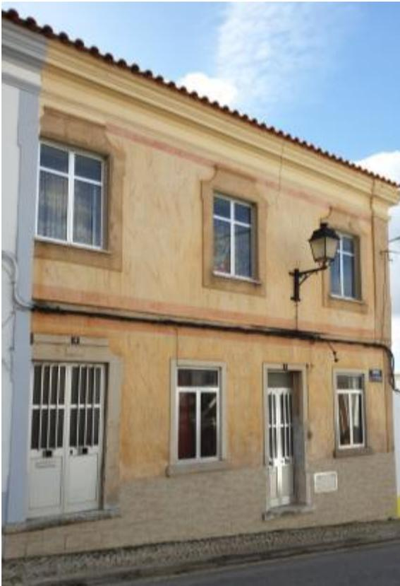
Figura 38. Exemplo de revestimento em pintura de fingidos num edifício na rua 5 de outubro, n.º 2 e 4
