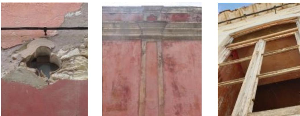
Figura 37. Exemplos de revestimentos existentes em edifícios na aldeia de Paderne – óculo, pilastra e teto interior junto ao vão
