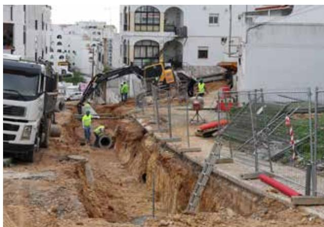
além das melhorias ao nível da circulação e segurança, irá dotar a zona de uma nova rede de abastecimento de água, com menos fugas e bastante mais resistente, nova rede de águas residuais domésticas, menos propensa a entupimentos, nova rede de escoamento das águas pluviais, novos ecopontos, novos postes de iluminação pública e um pavimento renovado que contribui para melhorar a mobilidade urbana”.
