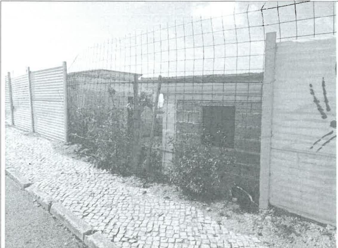
Foto nº4 - Vista da vedação com chapa metálica e rede metálica.
