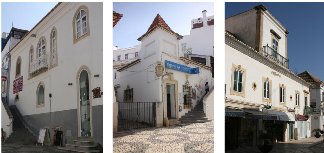
Figura 20, Figura 21 e Figura 22 – Edifícios de feição erudita existentes na rua 5 de outubro
