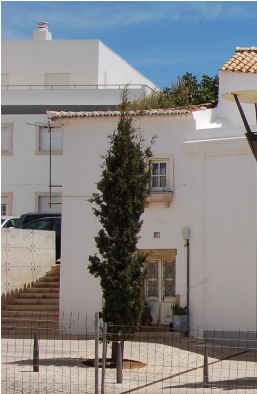
Figura 10 – Casa manuelina existente na Praça da República
