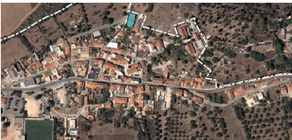
Figura 75. Localização dos edifícios devolutos
