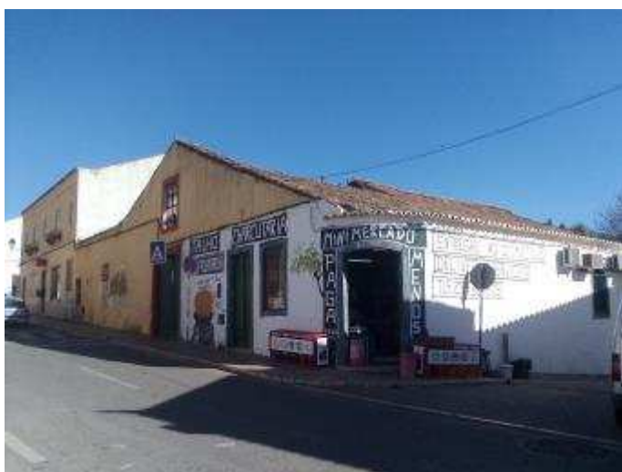
Figura 71. Mini-mercado “Paga Menos” com edifício parcialmente em ruína
