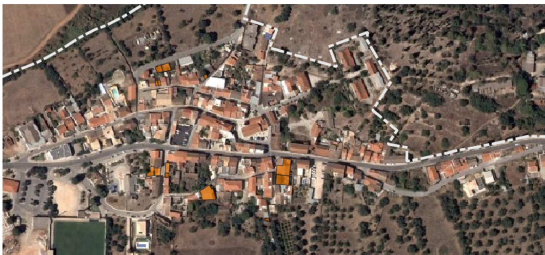
Figura 73. Localização dos edifícios em ruína
