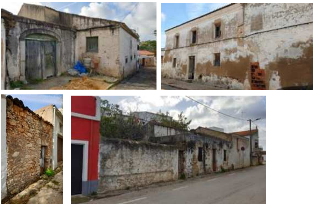
Figura 36. Exemplos de edifícios em ruína na área de intervenção da ARU
