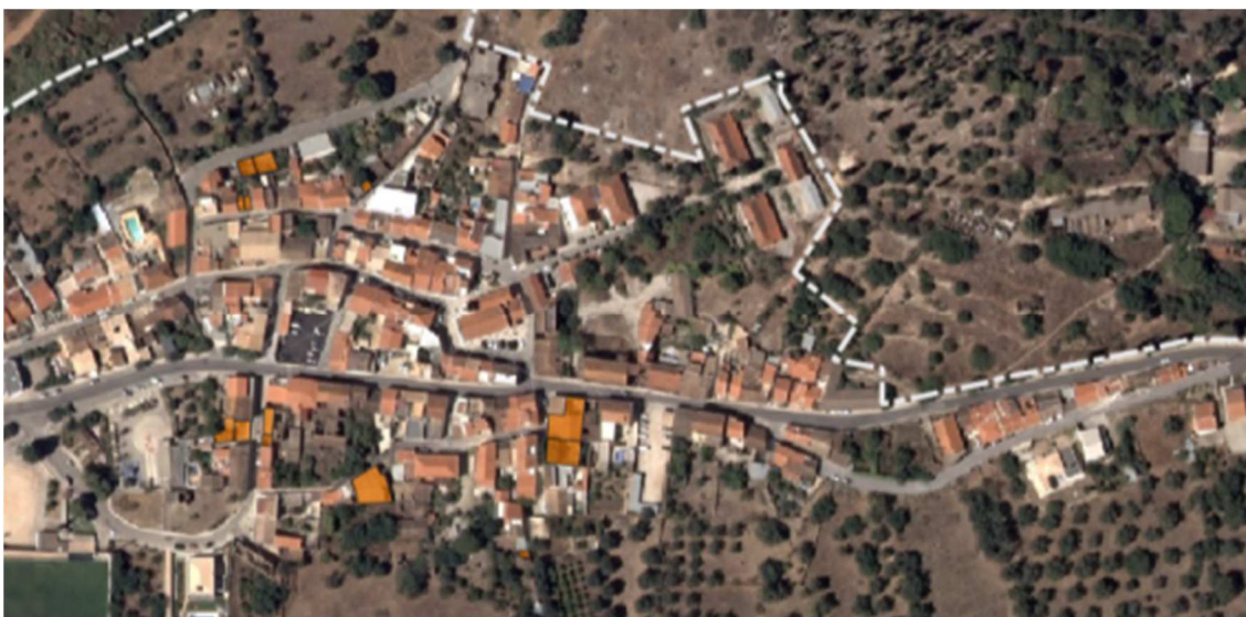
Localização dos edifícios em ruína
