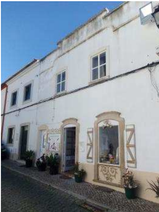
Figura 46. Exemplo de edifícios com cabos elétricos expostos nas fachadas
