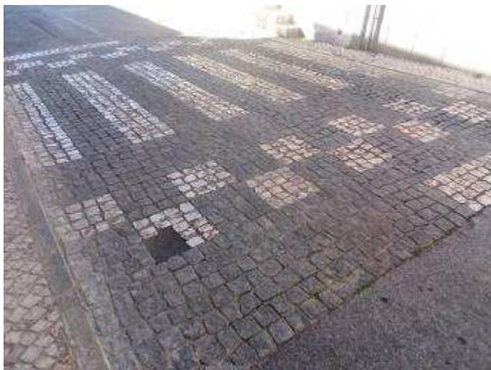
Figura 49. Passadeira sobreelevada na Rua 5 de outubro
