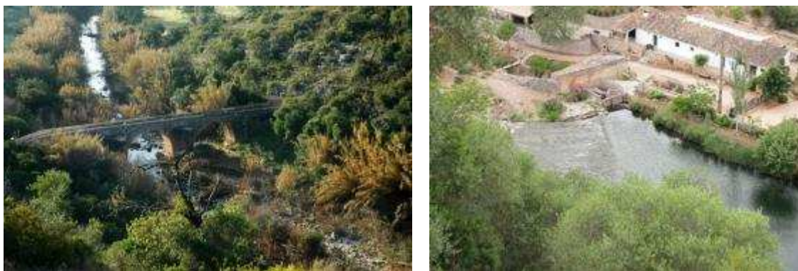
Figura 9. Ponte Romana Figura 10. Azenha
