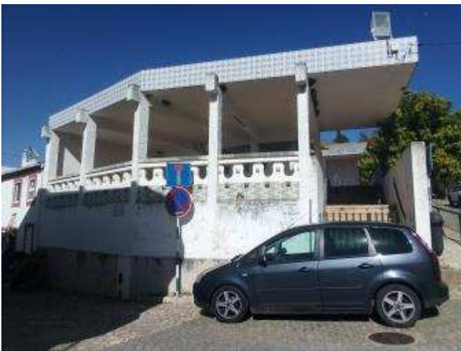
Figura 66. Edifício do antigo mercado, em avançado estado de degradação
