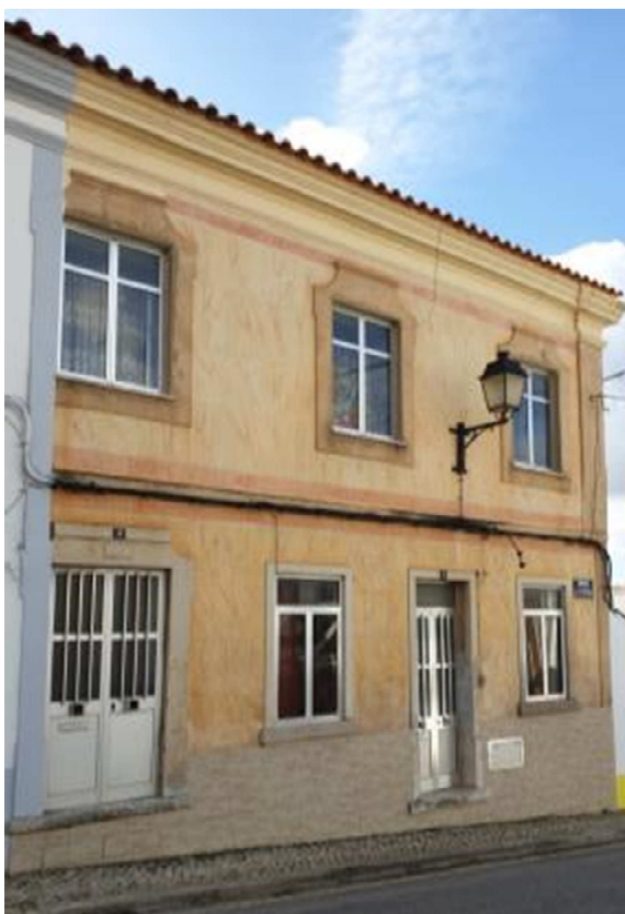
Figura 28. Exemplo de revestimento em pintura de fingidos num edifício na rua 5 de outubro, n.º 2 e 4
