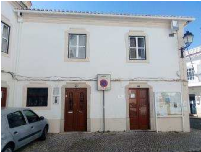
Figura 63. Edifício do Cartório Paroquial
