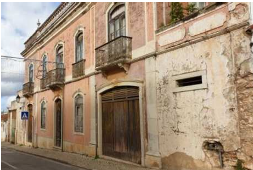
Figura 22. Edifício na Rua 5 de outubro, n.º 31 e 33
