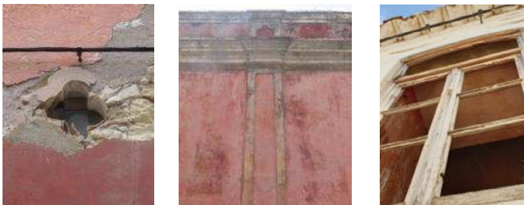
Figura 27. Exemplos de revestimentos existentes em edifícios na aldeia de Paderne – óculo, pilastra e teto interior junto ao vão
