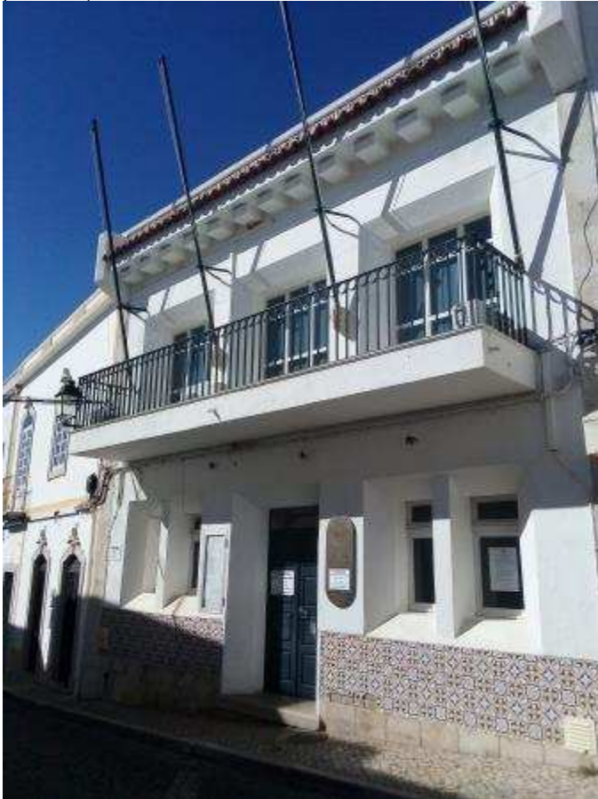
Figura 62. Edifício da Junta de Freguesia de Paderne
