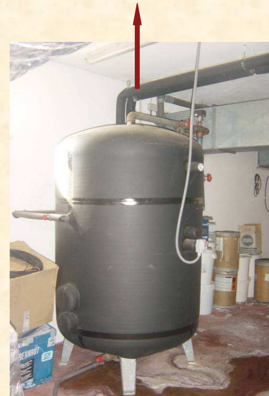
Deposito de Acumulação (existente)
