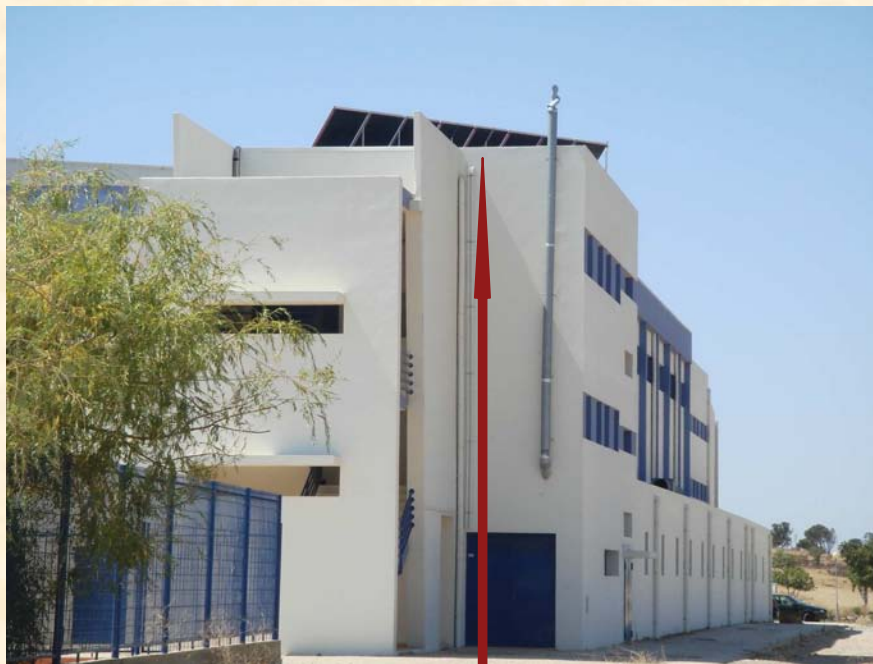
Baterias de Colectores Solares Instalados
